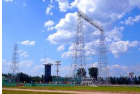
UHV (DC) test center
